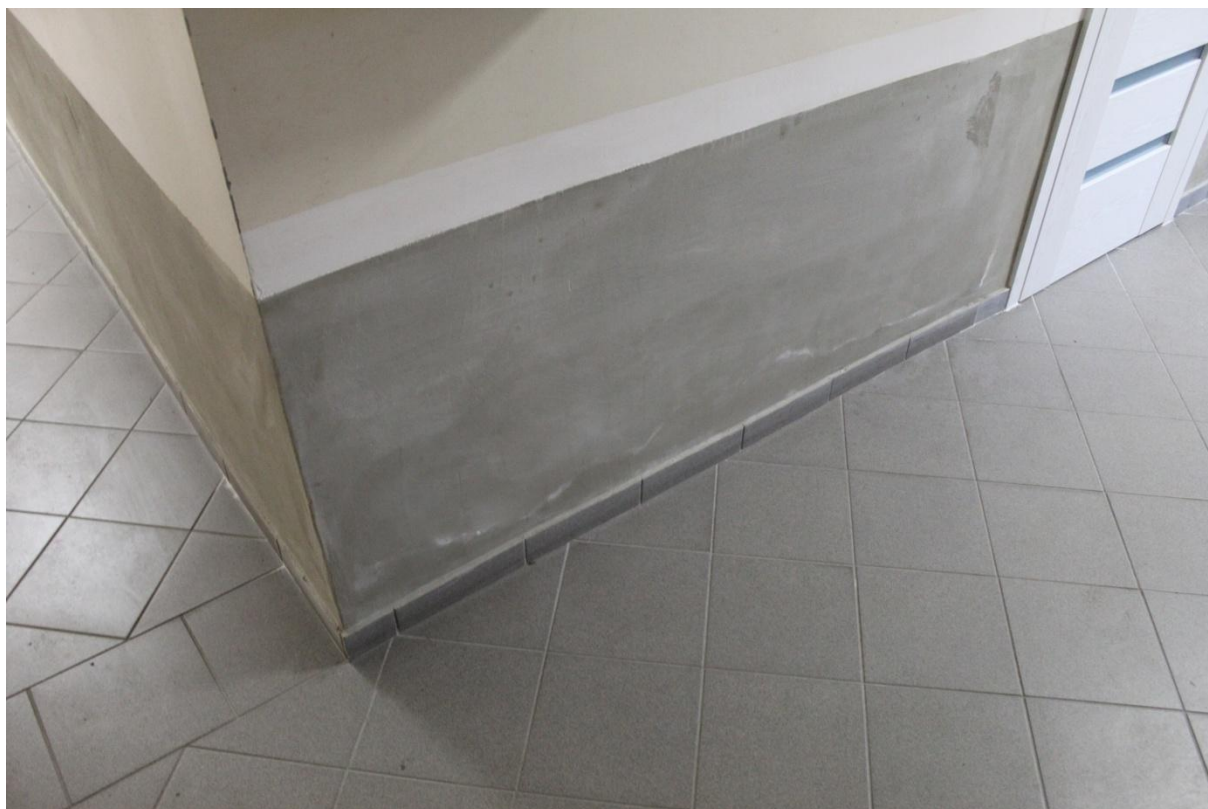
Fotografia 6. Ściana wewnętrzna korytarza. Mimo wykonanych prac naprawczych (wtórna izolacja materiałem uszczelniającym) widoczne zawilgocenie i miejscowe zasolenie ściany.
