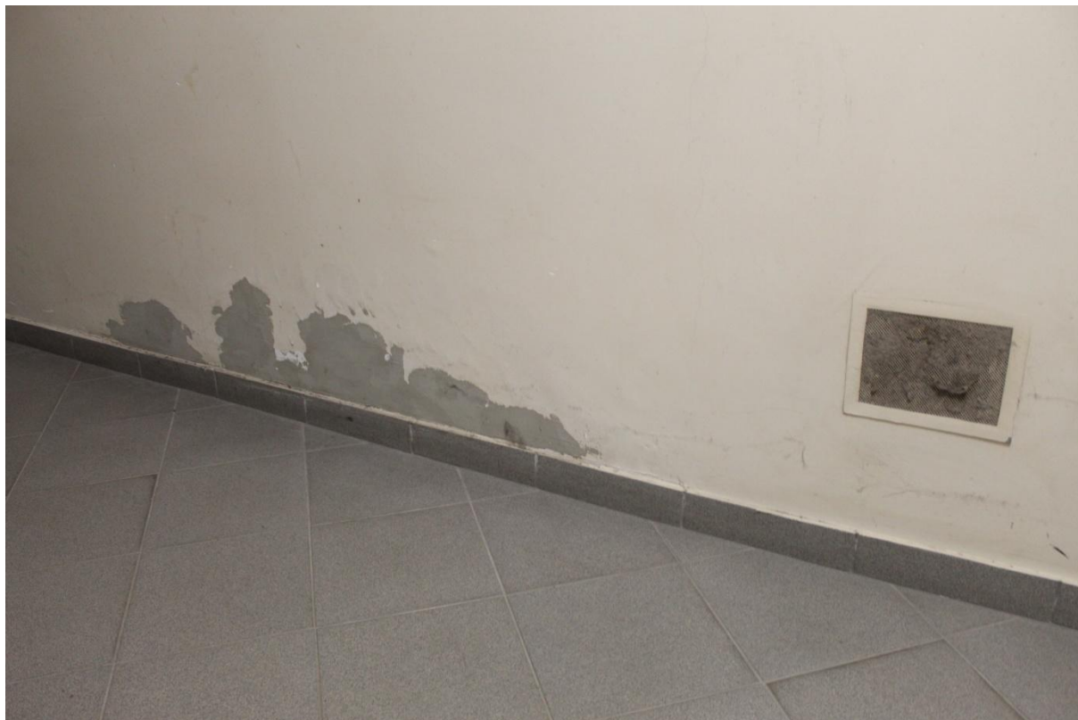
Fotografia 8. Ściana wewnętrzna korytarza. Widoczne zawilgocenie ściany, uszkodzenie tynku i wyprawy malarskiej.
