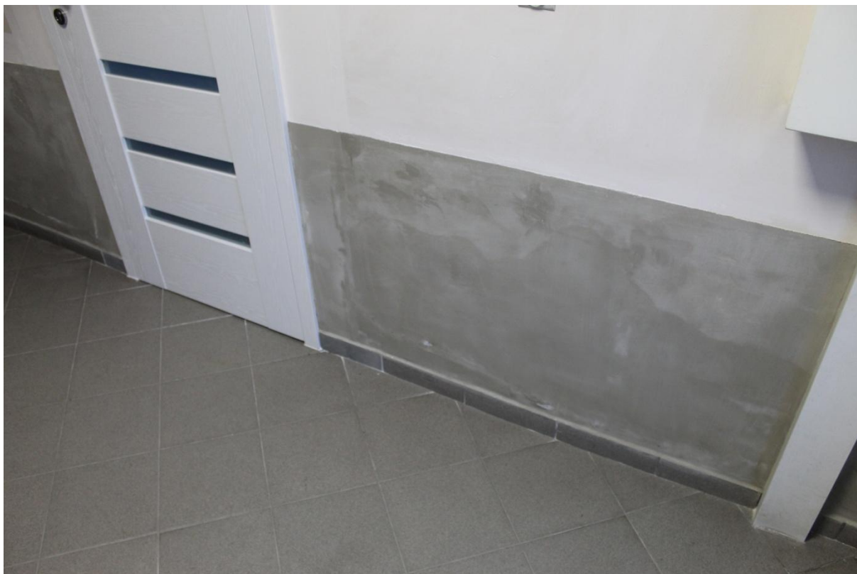
Fotografia 5. Ściana wewnętrzna korytarza. Mimo wykonanych prac naprawczych (wtórna izolacja materiałem uszczelniającym) widoczne zawilgocenie i miejscowe zasolenie ściany.
