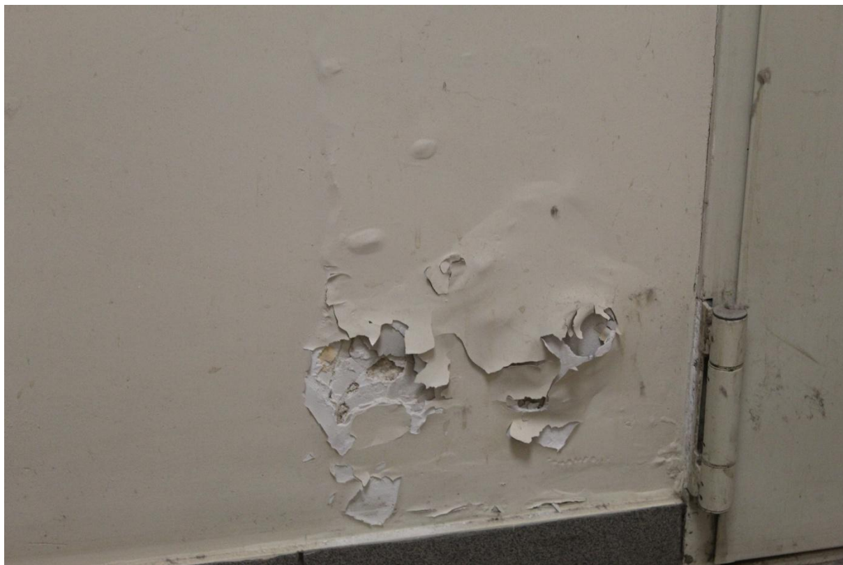
Fotografia 7. Ściana wewnętrzna korytarza. Widoczne zawilgocenie ściany, uszkodzenie tynku i wyprawy malarskiej.
