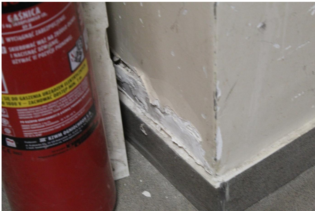
Fotografia 3. Ściana zewnętrzna w okolicy wejścia środkowego do budynku. Widoczne zawilgocenie ściany, uszkodzenie tynku i wyprawy malarskiej.
